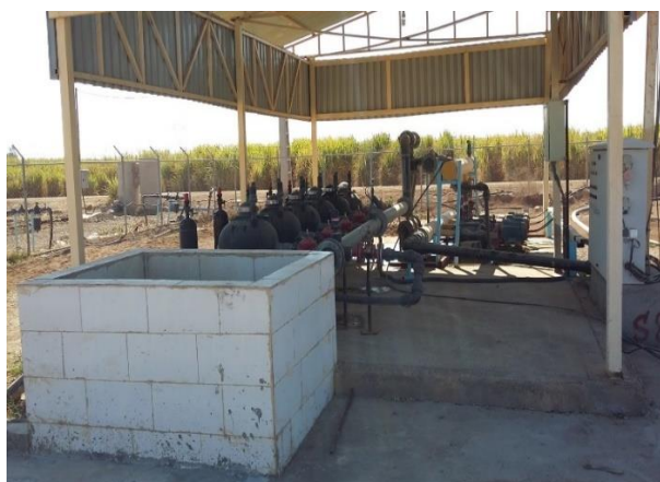
شکل ۲- شماتیک ایستگاه پمپاژ و فیلتراسیون در سیستم آبیاری قطره‌ای زیرسطحی Figure 2- Schematic of pumping and filtration station in subsurface drip irrigation
