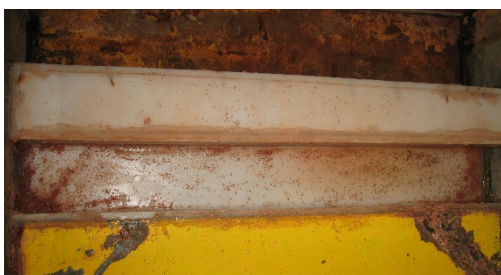
شکل ۳- تله ماسه نصب شده در انتهای فلوم Figure 3- The installed sand trap at the downstream of the flume
