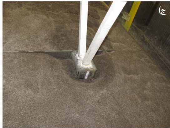
شکل ۱۰- تصاویر ابعاد چاله آبشستگی در تراز کارگذاری Z/D_* = 0 ، عمق نسبی y/D_* = 1 و سرعت نسبی 0.95 ، (الف) آستانه جلویی، (ب) آستانه میانی و (ج) آستانه انتهایی
