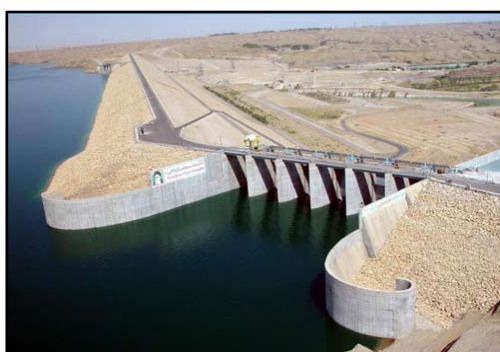
شکل ۲- نمایی از سد مخزنی کرخه Figure 2- Karkheh Reservoir Dam
